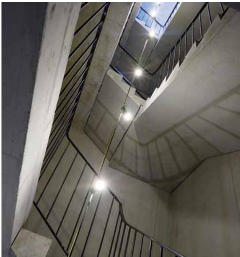
Das Treppenhaus aus rohem Beton versinnbildlicht die Reduktion aufs Wesentliche und den schonenden Umgang mit Ressourcen.
