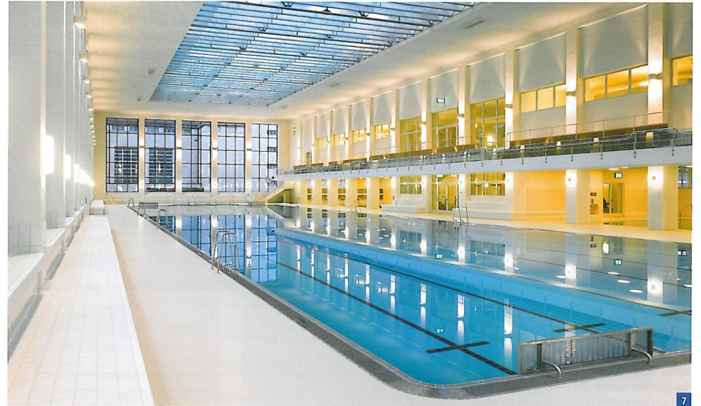
Um eine sommerliche Überhitzung zu unterbinden, sind einzelne Elemente der äusseren Dachverglasung als Öffnungsflügel ausgeführt.
